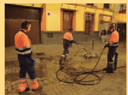
Tres operarios retiran la cera.
