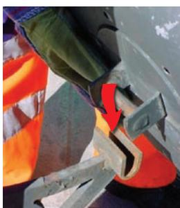
Colocamos de nuevo el cubo de forma que la parte inferior de éste encaje dentro del soporte de la parte inferior unida al poste de la papelera. (En todos los modelos actuales de la misma forma)
